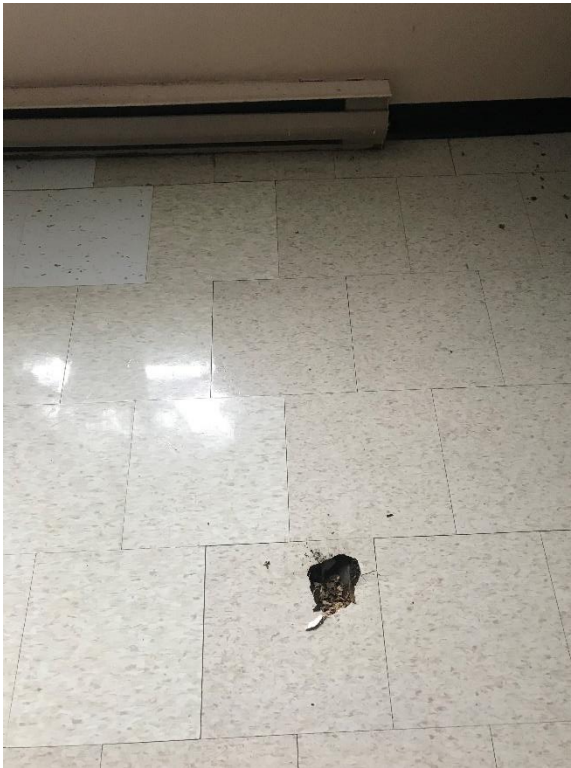
Photo 4837 – Dommages au plancher – trou et pourriture du platelage
