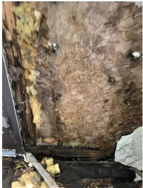
*Photo 4828 – Dommages structuraux mur arrière*
