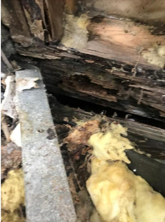
*Photo 4829 – Dommages structuraux mur arrière*
