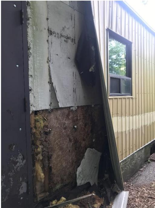
*Photo 4831 – Dommages structuraux mur arrière*
